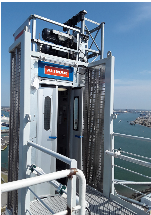
Van Oord Svanen Crane Ship
